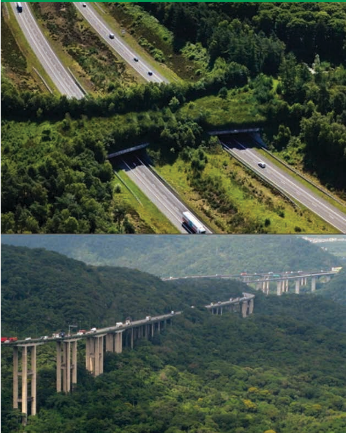
10 වන චිත්‍රය: වන සත්ව මාරු (crossings) සමඟ මහාමාර්ග ඒකාබද්ධ කරන උඩින් යන පාලම් (overpasses) සහ යටින් යන පාලම් (underpasses). අළු (grey) සහ කොළ (green) යටිතලයන් සඳහා සැලසුම් කරන විට මෙබඳු යටිතල භාවිතා කළ හැක. ඡායාරූප: ඉහළ: Ecoduct – Wildlife Bridge – the Netherlands alizul2 blog. පහළ: http://io9.gizmodo.com/5989331/how-well-live-in-a-future-where-cities-have-become-forests
